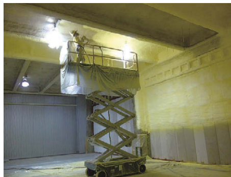
天井・壁：アキレスエアロンR施工
